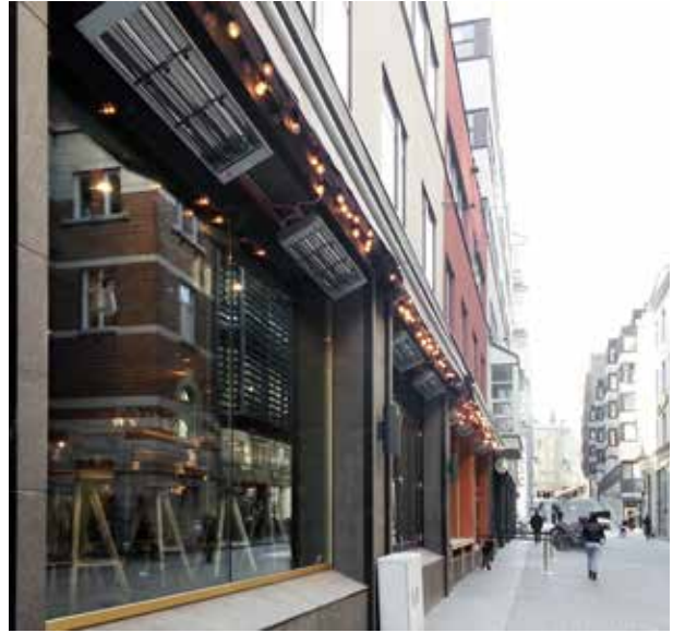
Der IR-Wärmestrahler kann in unterschiedlichen Winkeln montiert werden, um die Wärme dorthin zu richten, wo sie benötigt wird. Außenheizungen sollten unter dem Dach platziert werden.
